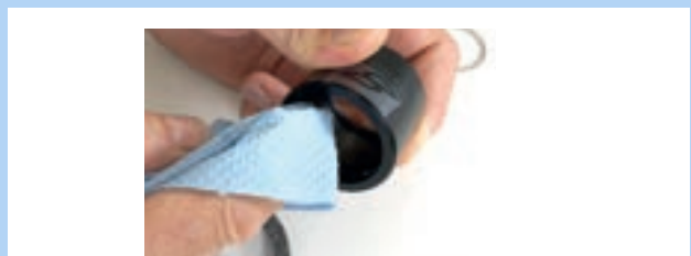
Abbildung 177: Außenhülse reinigen
